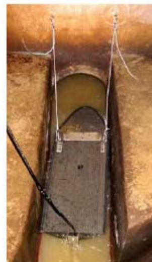
図 9-10: 下水内に取り付けたポンツーン
